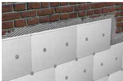
Płyty izolacyjne z poliuretanowej pianki utwardzanej 035 mocowane do cegły pełnej
