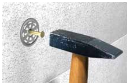
Wbijanie kołka mocującego płytę izolacyjną
