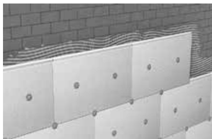
Płyty izolacyjne z poliuretanowej pianki utwardzanej 035 mocowane do muru z silikatów
