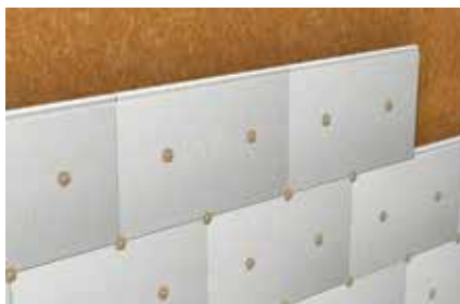
Mocowanie płyt styropianowych do płyt OSB
