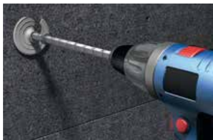
Osadzanie kołka termoz SV II ecotwist w płytach z utwardzonej pianki 032
