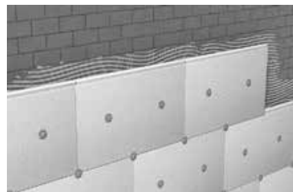
Mocowanie płyt z utwardzonej pianki O35 na bloczkach silikatowych
